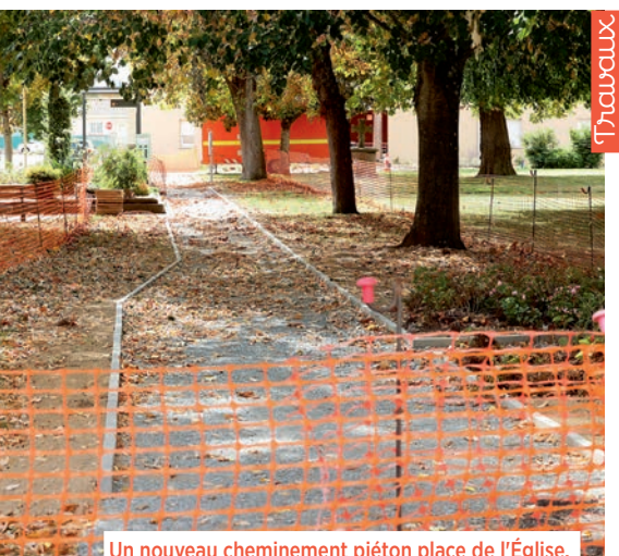
Un nouveau cheminement piéton place de l'Église.
