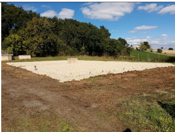
Pose d'un géotextile sur les filtres avec une couche de galets
