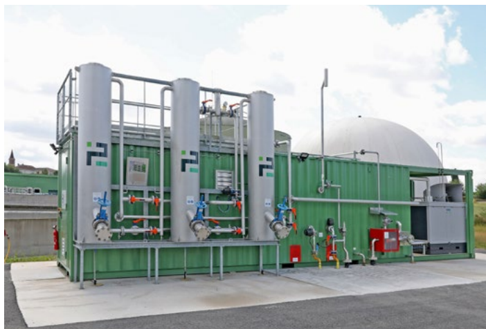
Unité de traitement de biogaz à la STEP Albi-Madeleine
