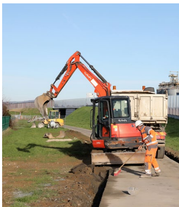
Aménagement d'une voie cyclable le long de la rocade d'Albi
