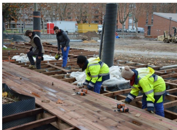
Chantier participatif sur le square Augereau à Cantepau
