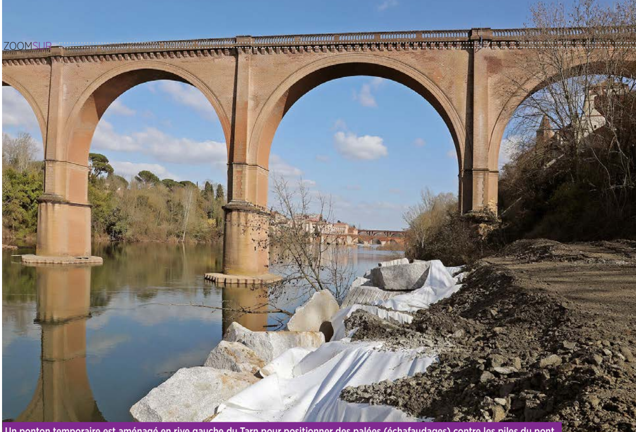
Un ponton temporaire est aménagé en rive gauche du Tarn pour positionner des palées (échafaudages) contre les piles du pont.
