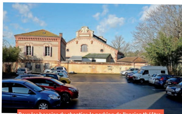
Pour les besoins du chantier, le parking de l'ancien théâtre de verdure est fermé temporairement.
