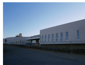
Construction de la nouvelle école
