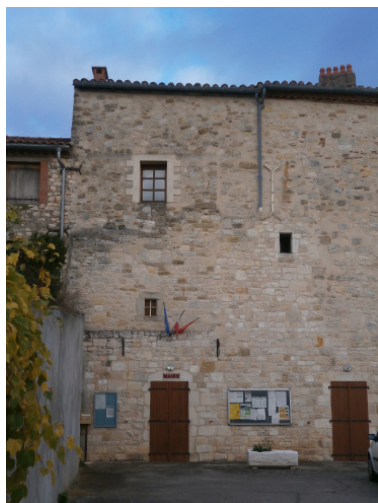
Logement communal au dessus de la mairie
