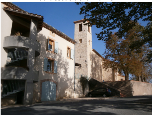
Logement communal au dessus de la mairie
