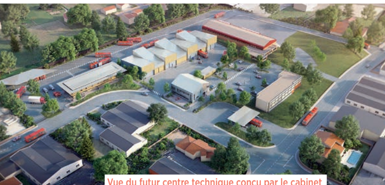
Vue du futur centre technique conçu par le cabinet d'architectes Marjan Hessamfar & Joe Verons.
