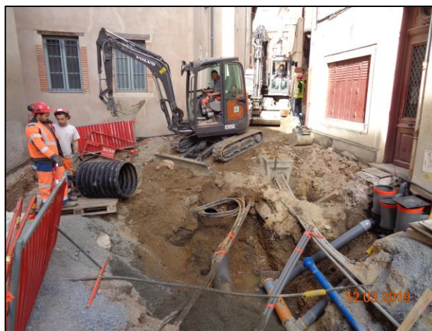
Renouvellement de réseaux rue des Pénitents à Albi
