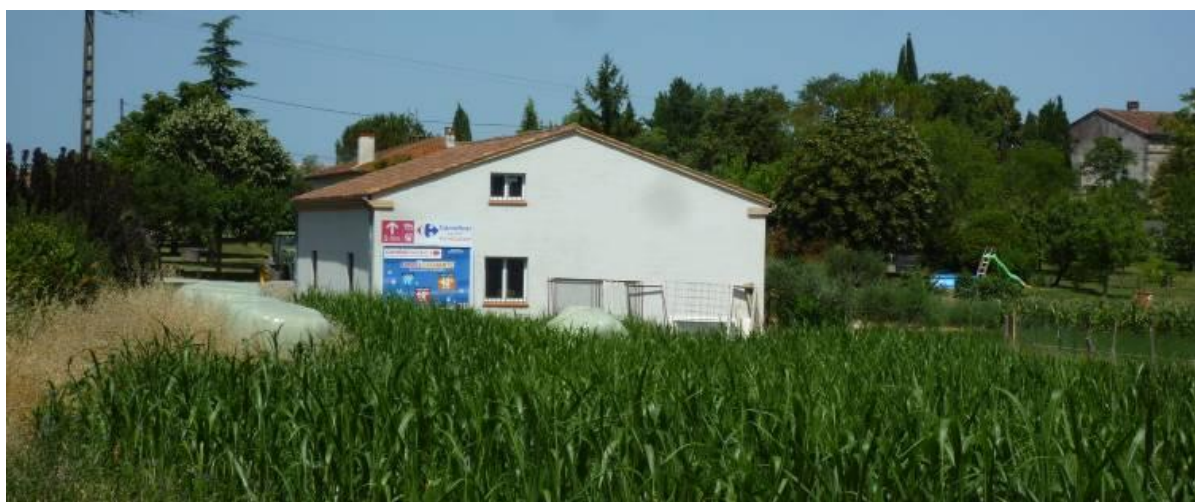
33. Panneau mural non conforme
