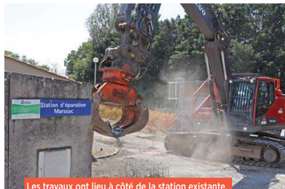
Les travaux ont lieu à côté de la station existante.
