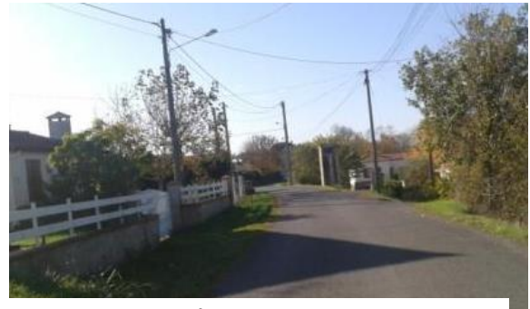
Cas d'une route bordée d'habitations sans qu'un trottoir ait été réalisé
