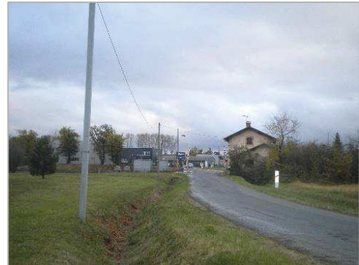
Illustration 23 : Vue depuis la RD 13 sur les bâtiments d'activité de Terssac
