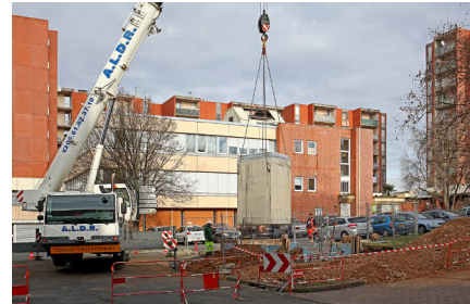
INSTALLATION DE CONTENEURS ENTERRÉS (QUARTIER DE CANTEPAU - ALBI)
