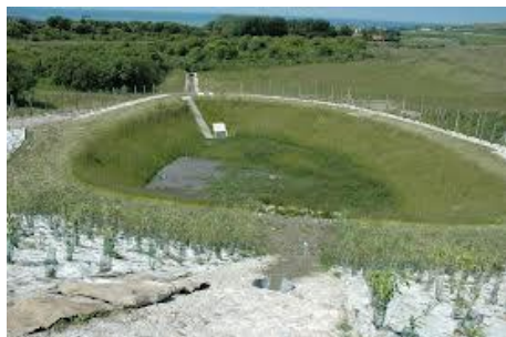
Bassin de rétention
