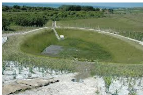
Bassin de rétention
