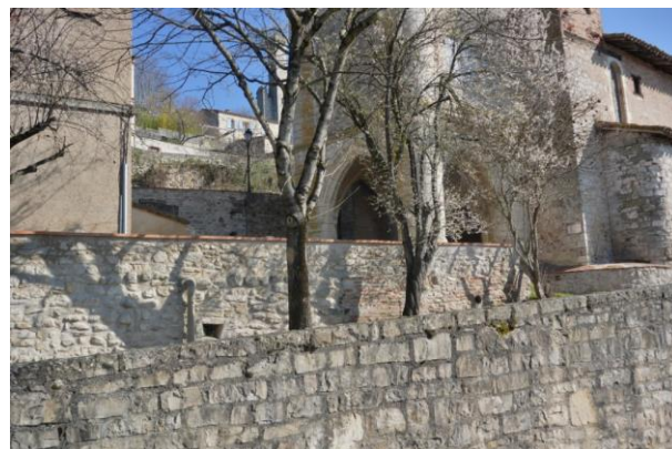
Terrasses et murets
