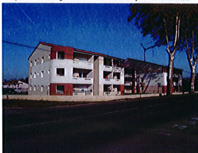
ZAC de Bourdelas Opération de logements en locatif aidé par Tarn Habitat
