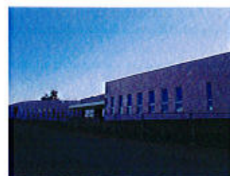
Construction de la nouvelle école
