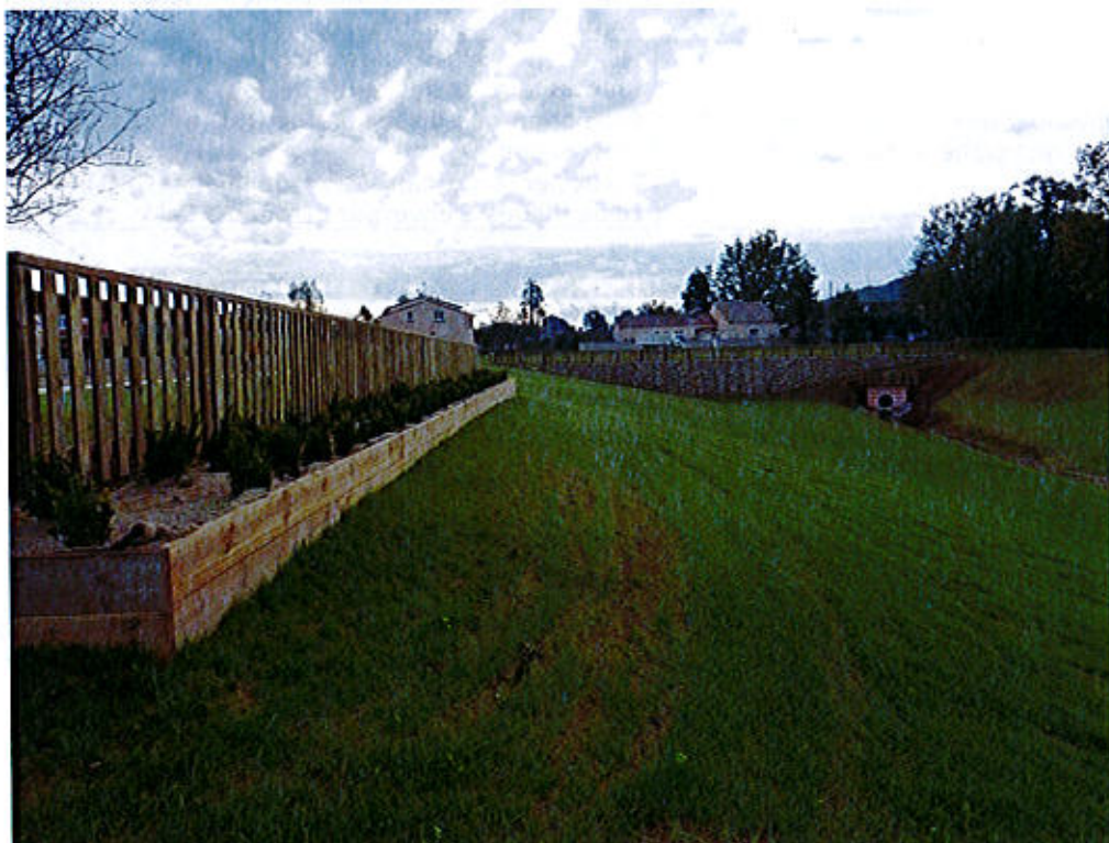
Aménagement paysager du bassin de rétention du Marranel
