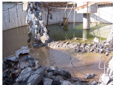
Démolition de la STEP de Lescure : combiné « bassin biologique / clarificateur » en cours de démantèlement
