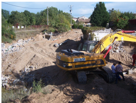
Démolition de la STEP de St Juery
