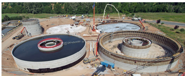
Construction des bassins circulaires extérieurs en juin 2009 (dont un bassin mise en eau)
