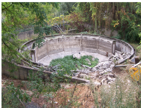
Démolition de la STEP d'Arthès: combiné « bassin biologique / clarificateur » en cours de démantèlement
