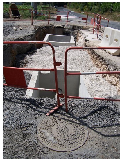
Comptage débitmétrique- Secteur Jourdes : Mise en place des ouvrages de bypass et de comptage sur la Route de Fauch
