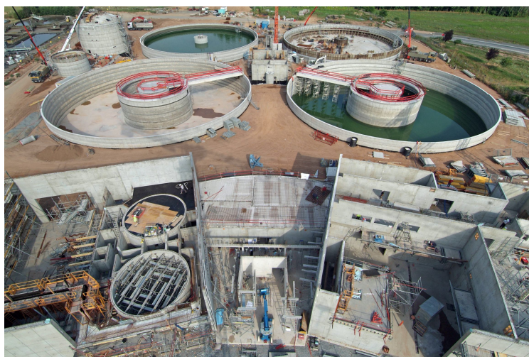
Vue d'ensemble des ouvrages en construction : au premier plan le bâtiment principal, au second plan les ouvrages circulaires (bassins biologiques et clarificateurs) et enfin au second plan à gauche le digesteur.
