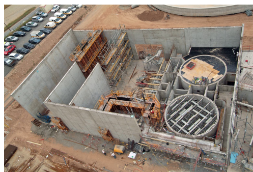
Construction du bâtiment principal zone « prétraitement » : vue des deux bassins Dessableur-dégraisseur
