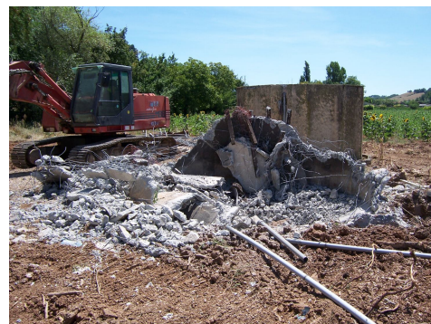
Démolition de la STEP de Jourdes (Puygouzon)
