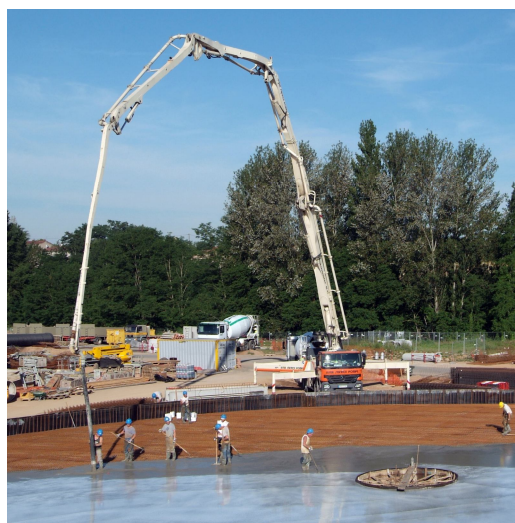
Mise en œuvre du béton du fond de radier d'un des clarificateurs après ferrailage.
