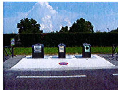
Conteneurs enterrés avenue Kellermann à ALBI
