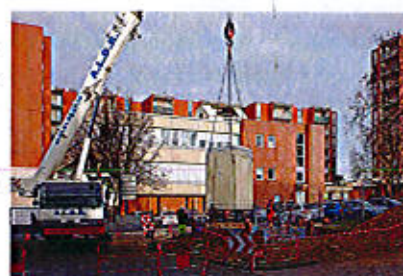
INSTALLATION DE CONTENEURS ENTERRÉS (QUARTIER DE CANTEPAU - ALBI)
