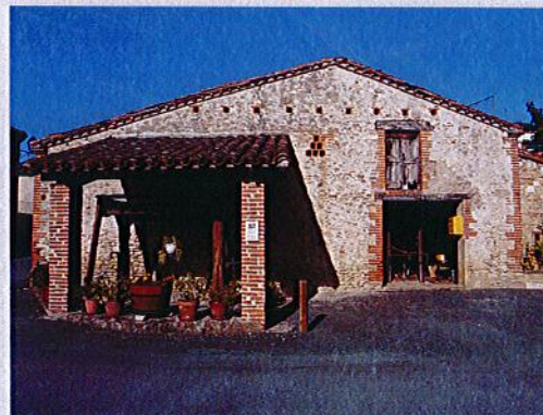
Réhabilitation du centre-bourg
