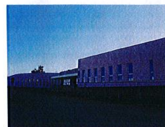
Construction de la nouvelle école
