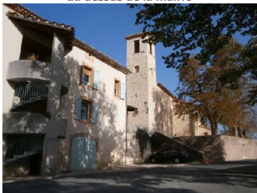
Logement communal au dessus de la mairie
