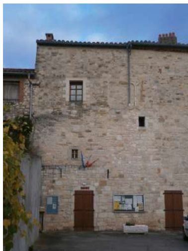
Logement communal au dessus de la mairie
