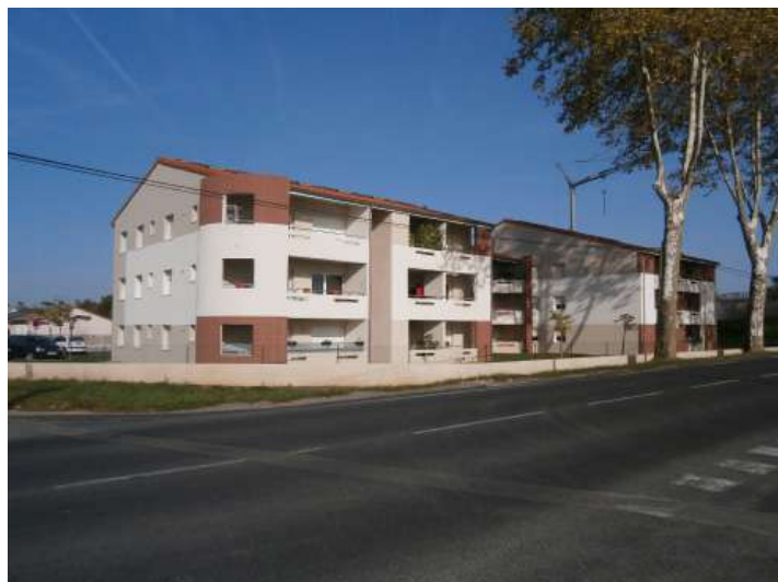
ZAC de Bourdelas Opération de logements en locatif aidé par Tarn Habitat
