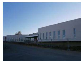
Construction de la nouvelle école
