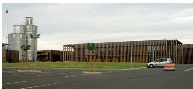
Bâtiment d'activité, ZA Fonlabour, Tersac
