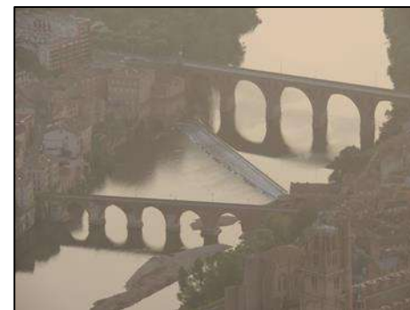
Les franchissements du Tarn à Albi
