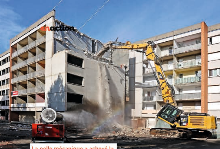
La pelle mécanique a achevé la déconstruction du 26-28 avenue Kellermann.
