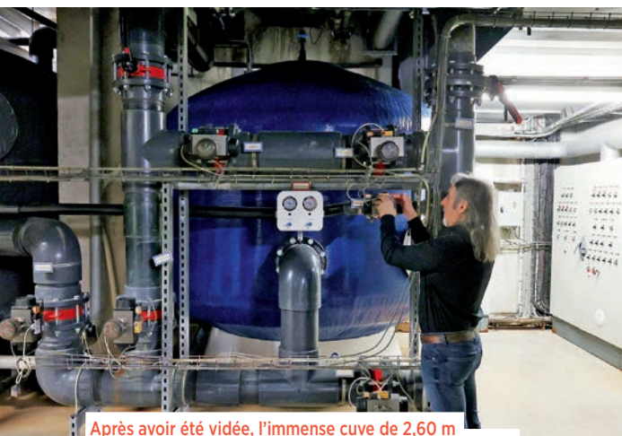
Après avoir été vidée, l'immense cuve de 2,60 m de diamètre a été coupée en deux avant d'être évacuée.
